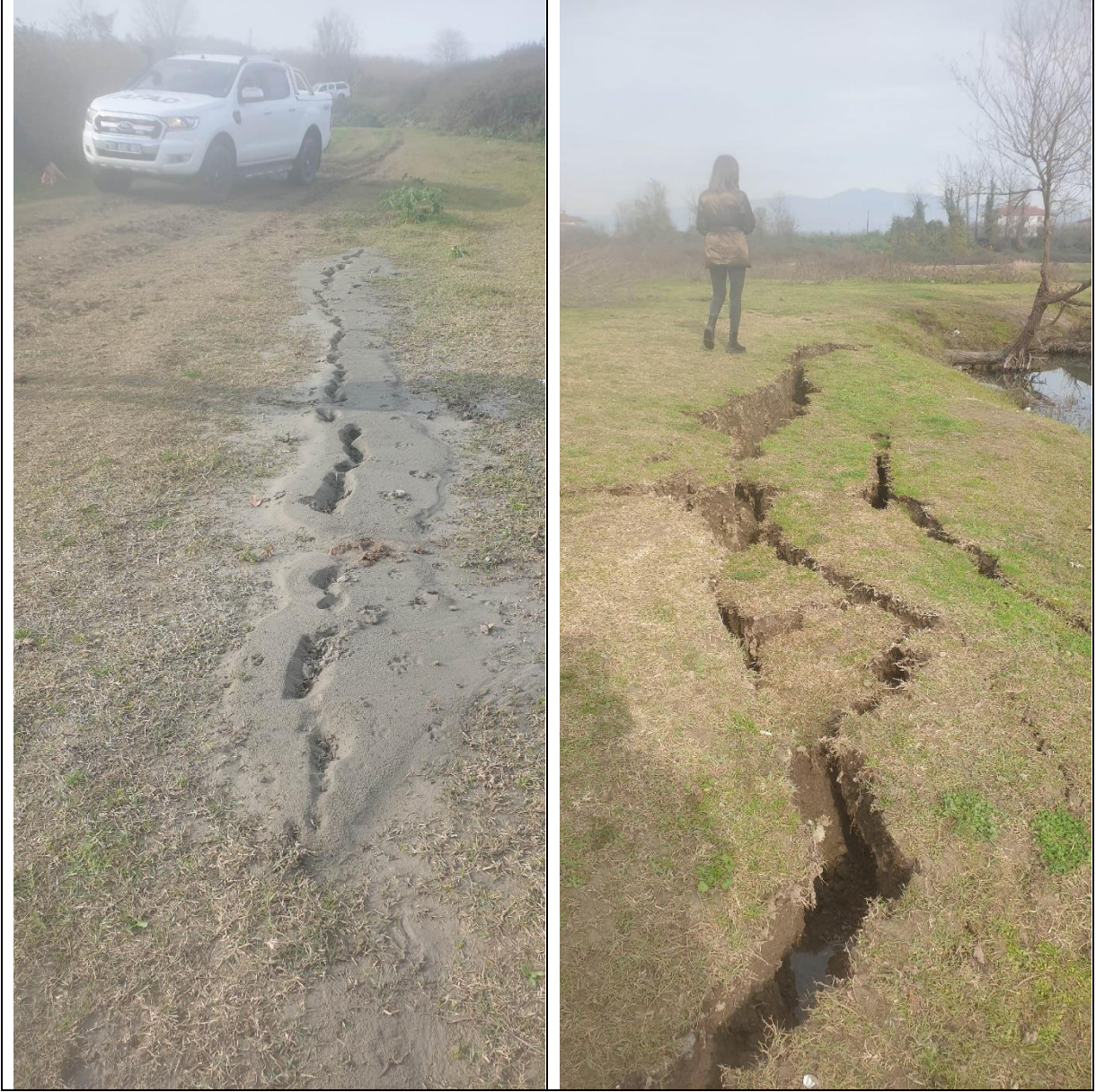
Şekil 12. Düzce depremi sırasında/hemen sonrasında gelişen zemin sıvılaşması (sol) ve yanıl yayılmaya (sağ) ait arazi fotoğrafları
