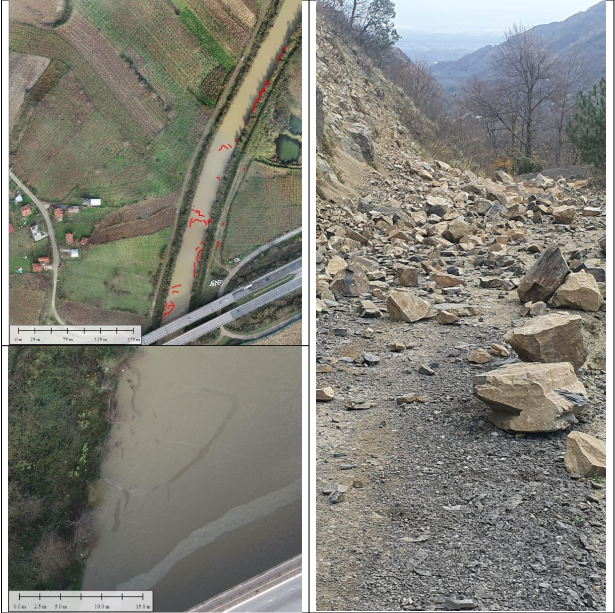
Şekil 14. Düzce depremi sırasında/hemen sonrasında Melen Çayı içinde gelişen yanal yayılma ve Karadere Fay şevi önünde gelişen kaya düşmesine ait arazi fotoğrafları. Kırmızı kalem Melen Çayı kıyısı boyunca gelişen yanal yayılma izlerini göstermektedir.
